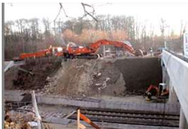
Opération de remblais
