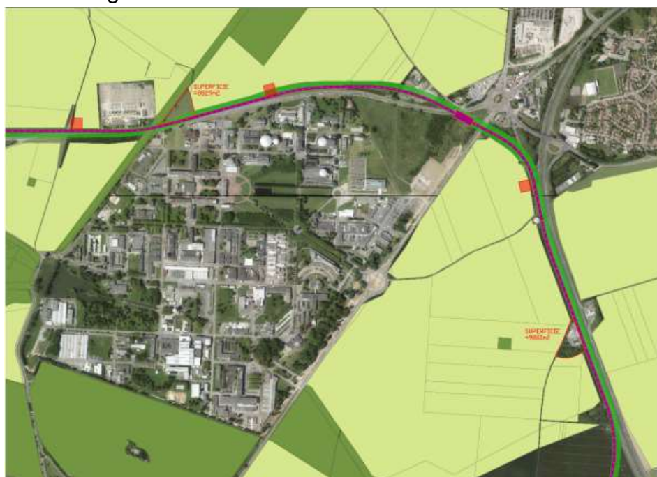
Localisation potentielle des ouvrages à partir d'Orsay-Gif
