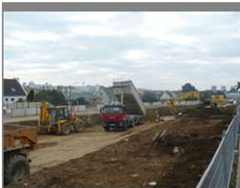
Opération de terrassement
