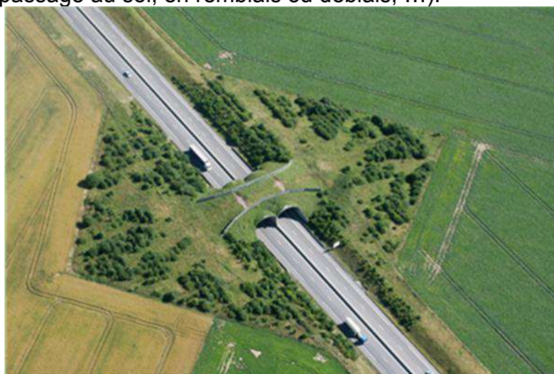
Exemple de passage grande faune
