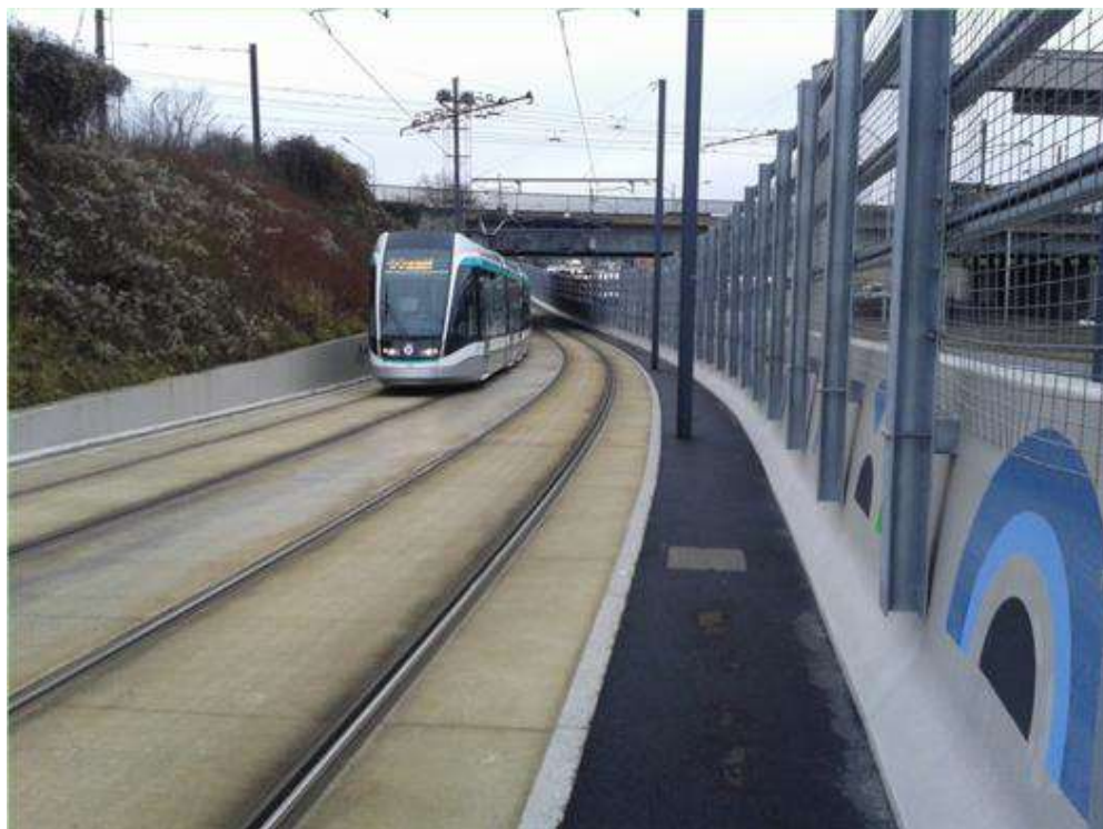
Dispositif de protection entre la plate-forme tramway du T7 et l'A86
