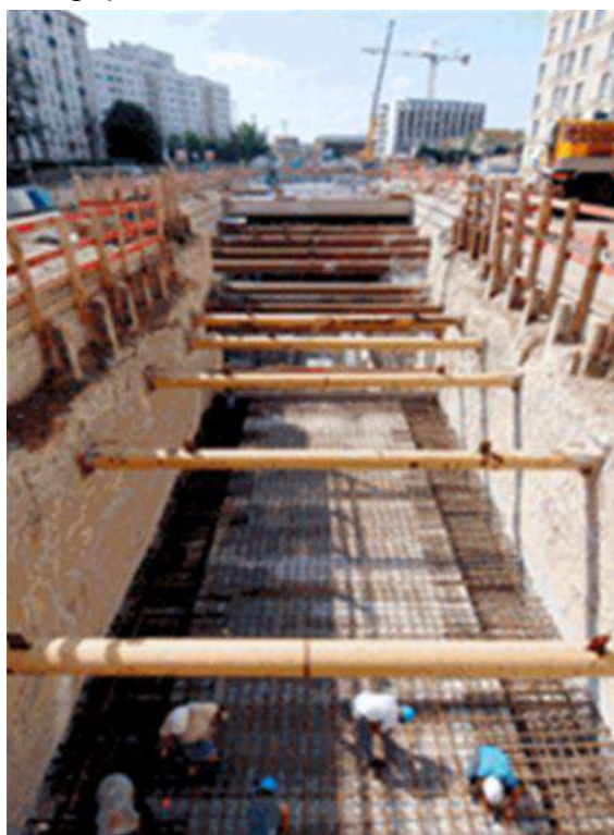
Exemple de tranchée couverte
