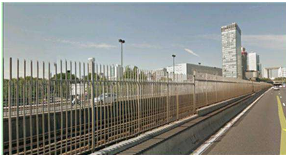
Dispositif de protection entre la ligne 1 du métro et l'A14 (Pont de Neuilly)
